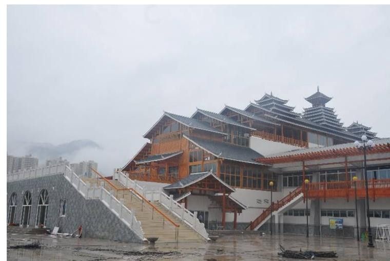
项目位于贵州省黔东南苗族侗族自治州榕江县，内设50×50m正式比赛池和25×25m训练池，总建筑面积11455m<sup>2</sup>，占地面积6180m<sup>2</sup>，建筑地下一层，地上两层，建筑高度为20.05m。二层以上采用木结构体系。
